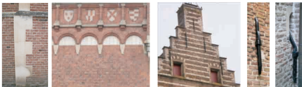
Metselwerk met natuursteen hoekstenen, boogfriezen, gevelafdekking, gevelankers
