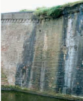
Uitspoeling van ijzersporen
