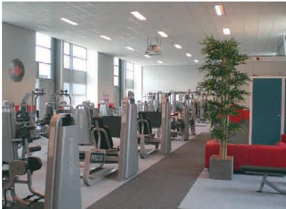
Verlichtingsarmaturen in nieuwstaat
